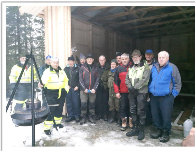
Garasjen står ferdig. Mønsåskanna på fjellet 4.12.2016
